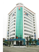
Cty CP Xây lắp TT Huế
