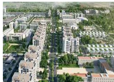
Hệ thống chiếu sáng công cộng Đô Thị Đắk Đoa, Gia Lai
